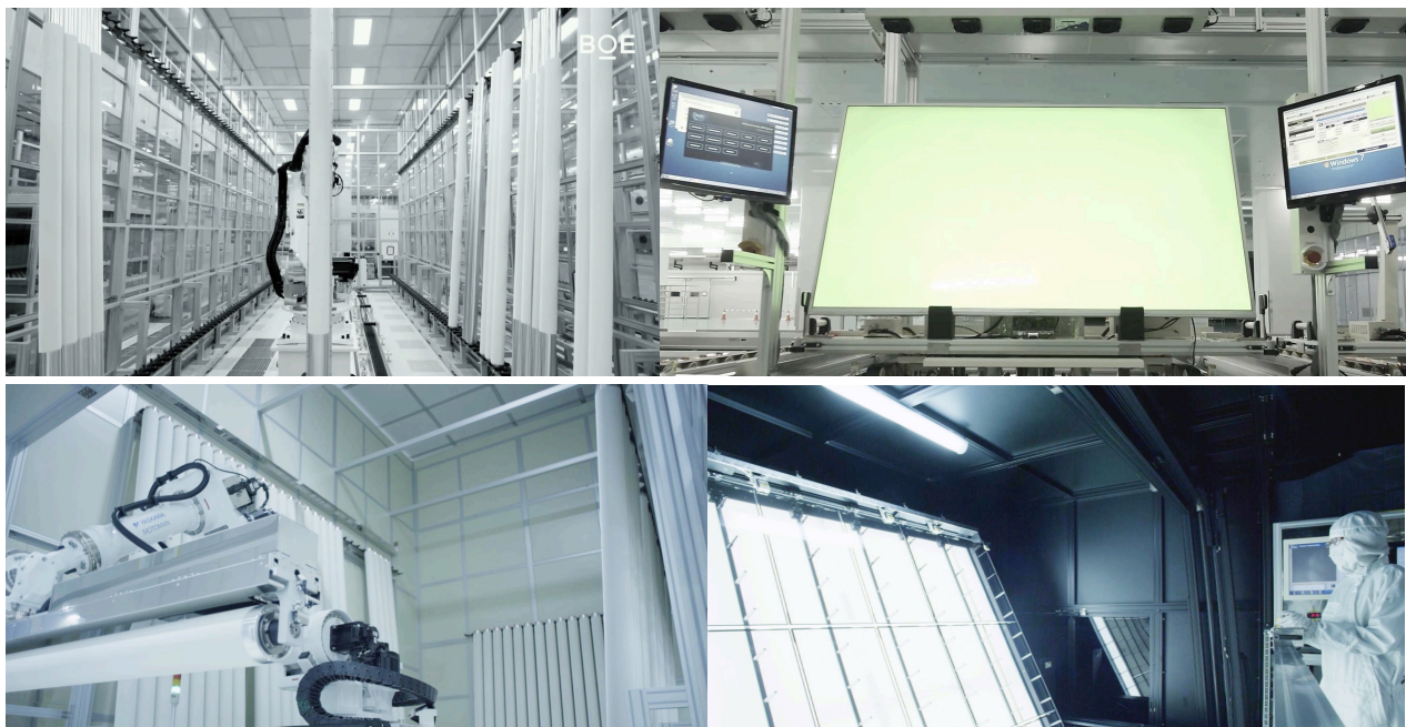
大型空调无尘工作间，恒温恒湿
